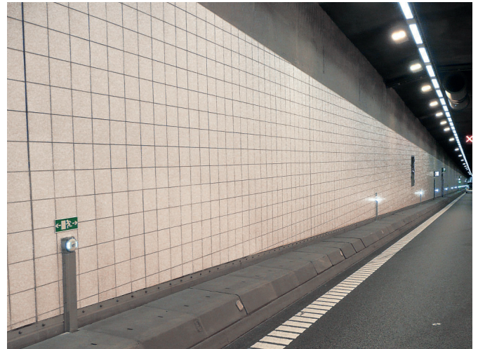
Tunnel Limfjord Dänemark
