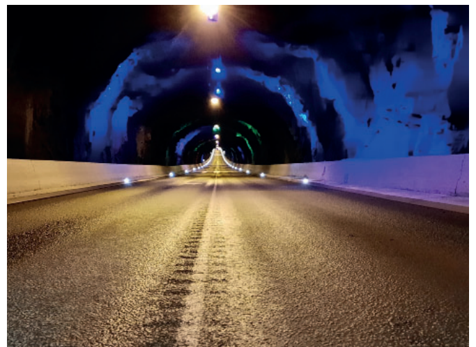
Tunnelbeleuchtung Nordoyatunnel Färöer
