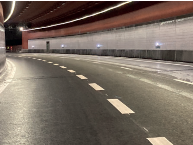
Mariefholmstunnel Göteborg Schweden
