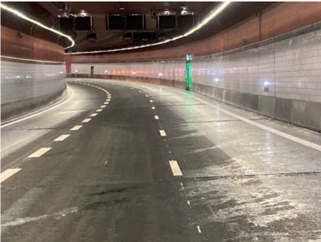
Mariefholmstunnel Göteborg Schweden
